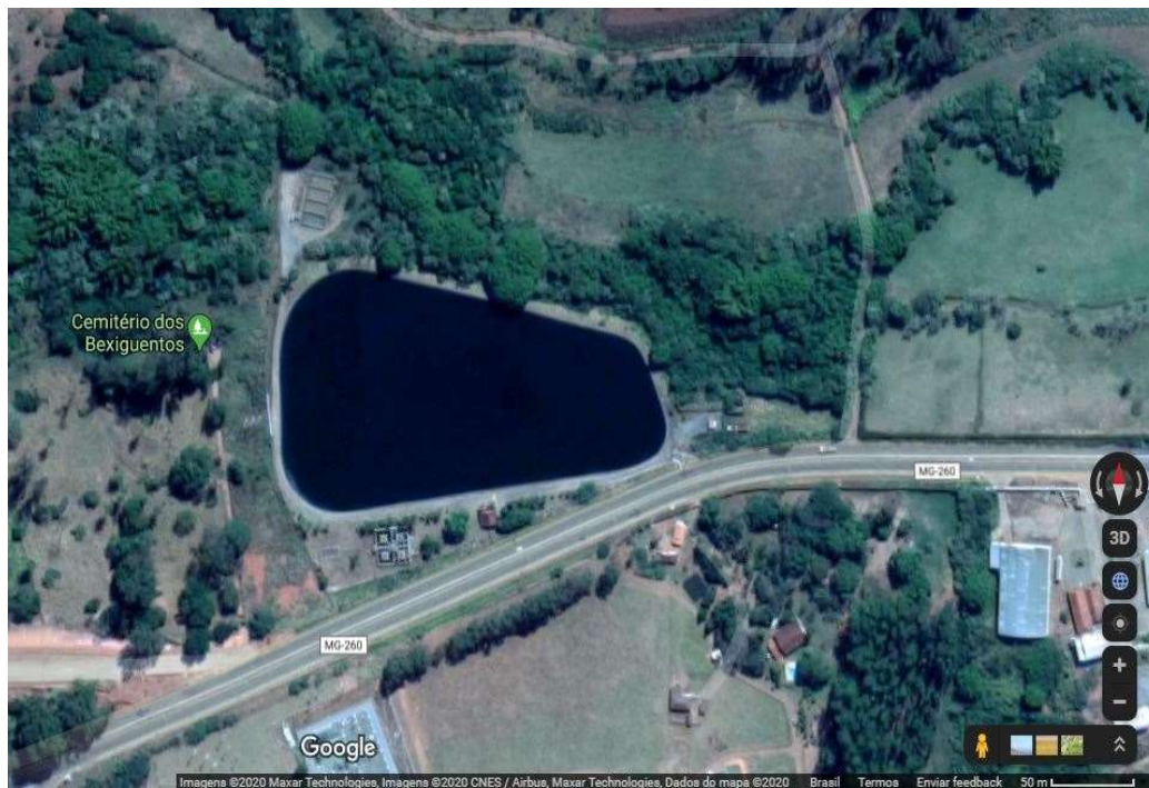
Figura 48 - Estação de tratamento de esgoto de Itapecerica
