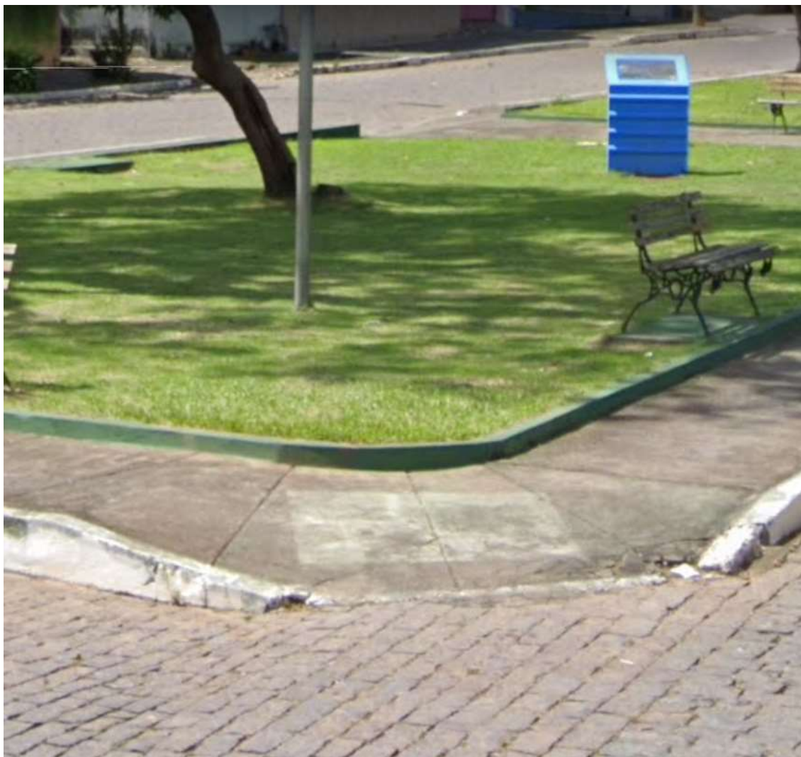
Figura 60 - Rampa de acesso no centro da cidade
