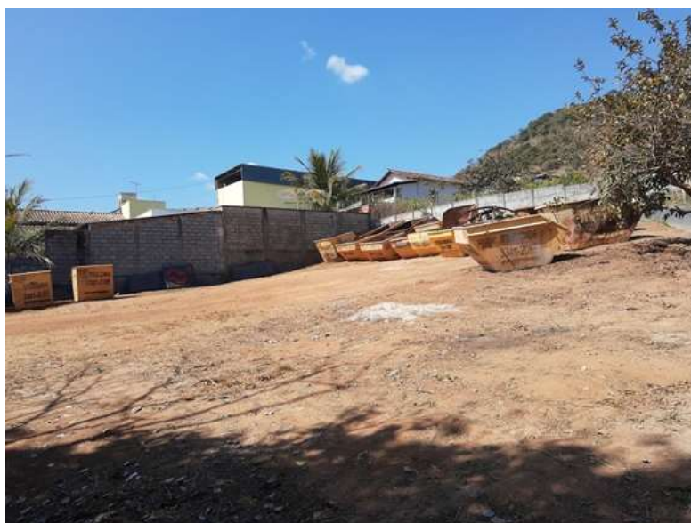
Figura 80 - Pátio da empresa que realiza a coleta de RCC
