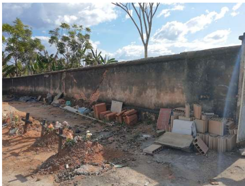
Figura 82 - Acúmulo de RCC no cemitério do distrito de Neolândia
