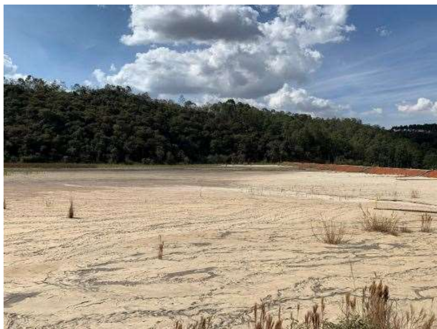
Figura 52 - Reservatório – Vista para a barragem
