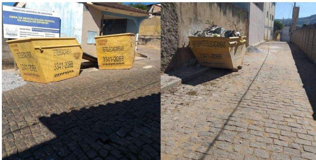
Figura 81 - Caçambas utilizadas na coleta de RCC
