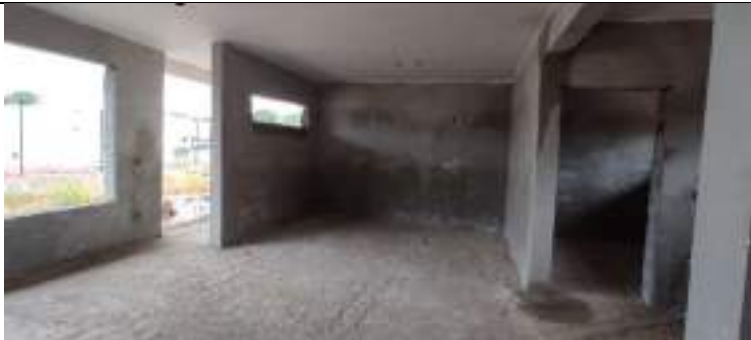
Descrição: Interno - Bloco Pedagógico 1
