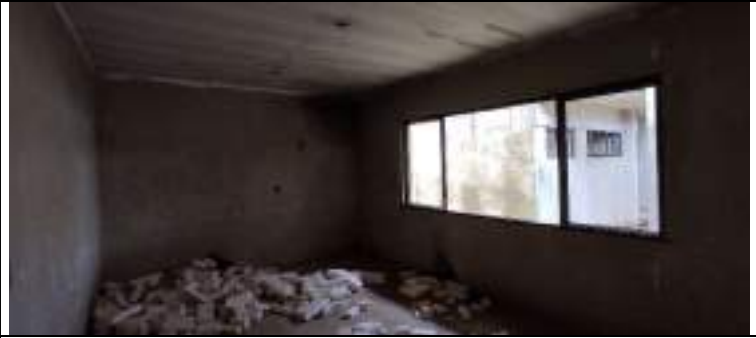
Descrição: Bloco administrativo
