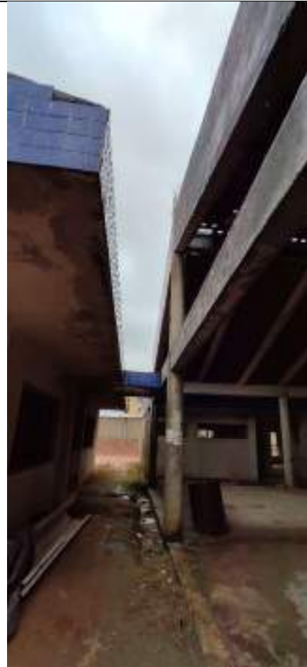
Descrição: Local da Obra – Pátio Externo
