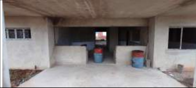
Descrição: Bloco administrativo
