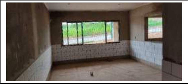
Descrição: Bloco administrativo
