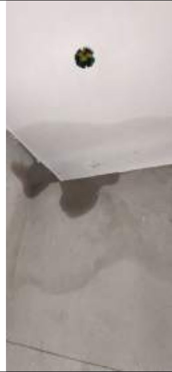
Descrição: Interno - Bloco Pedagógico 1
