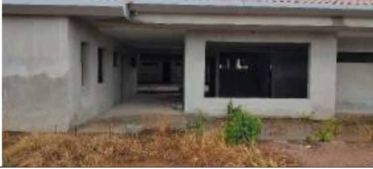
Descrição: Externo - Bloco Pedagógico 1
