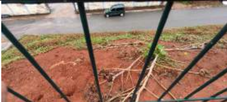
Descrição: Talude a reforçar
