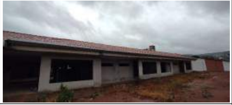
Descrição: Externo - Bloco Pedagógico 1
