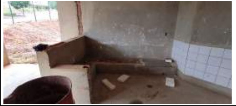
Descrição: Bloco administrativo
