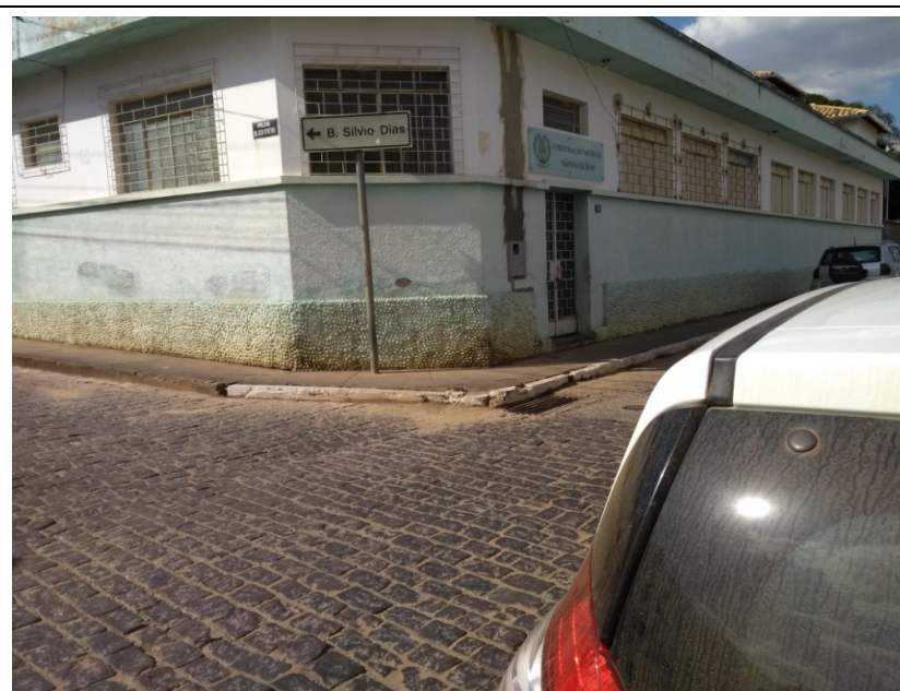
Descrição: Vista Parcial externa
