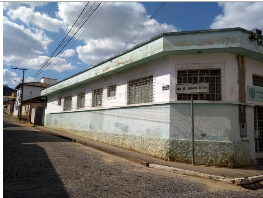
Descrição: Vista Parcial externa
