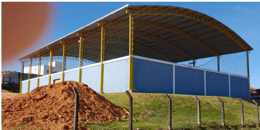
Descrição: Vista Parcial externa
