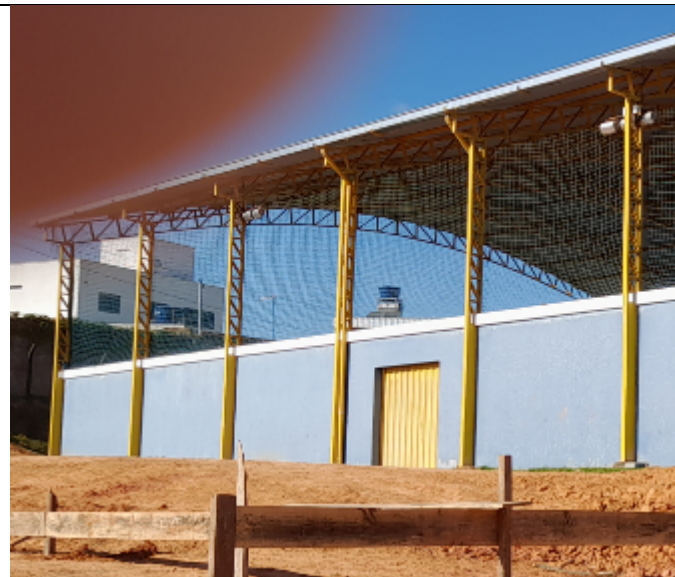
Descrição: Vista Parcial externa
