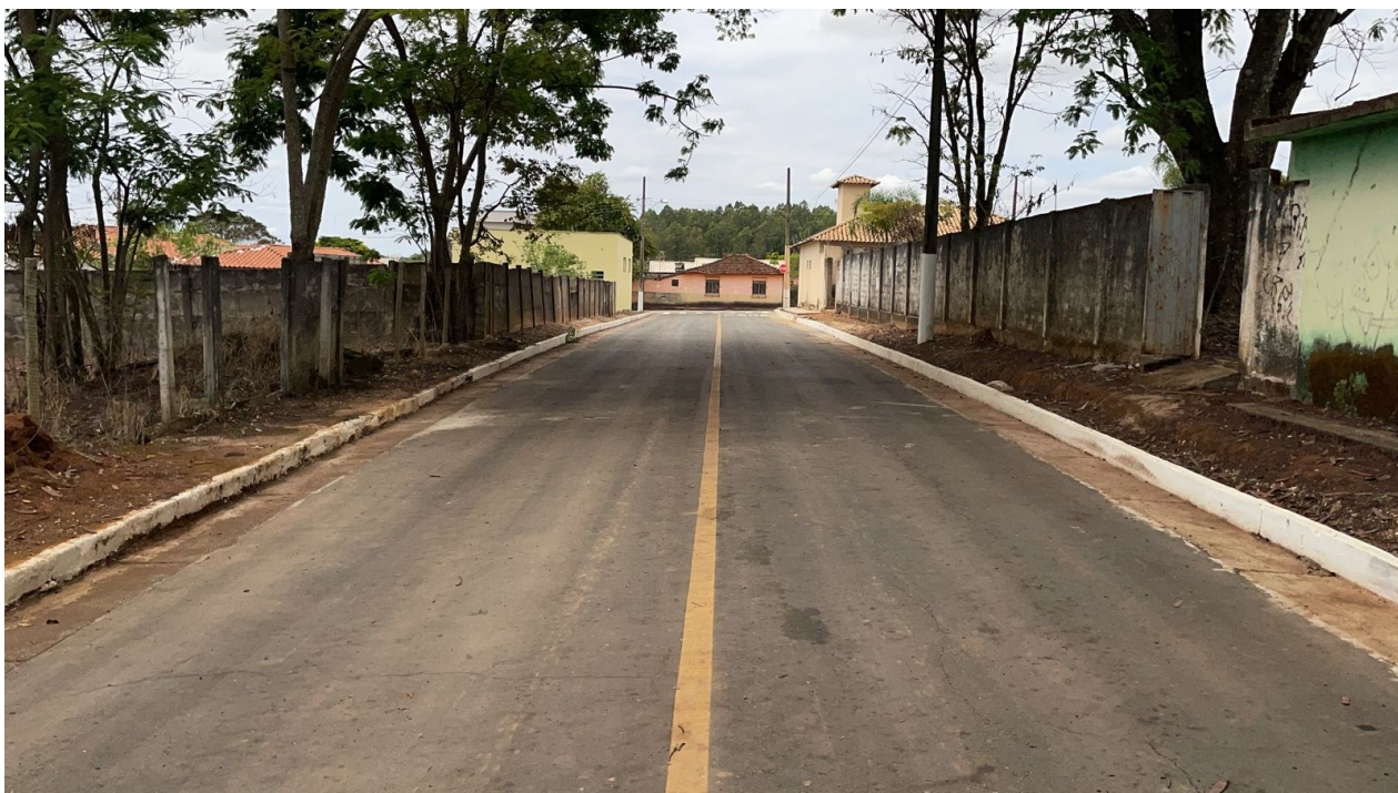
Foto 06 – RUA JOSÉ GOMINHO / LAMOUNIER
