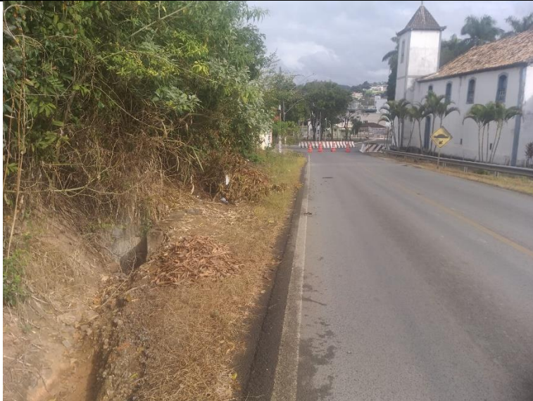
Descrição: Construção da Canaleta
