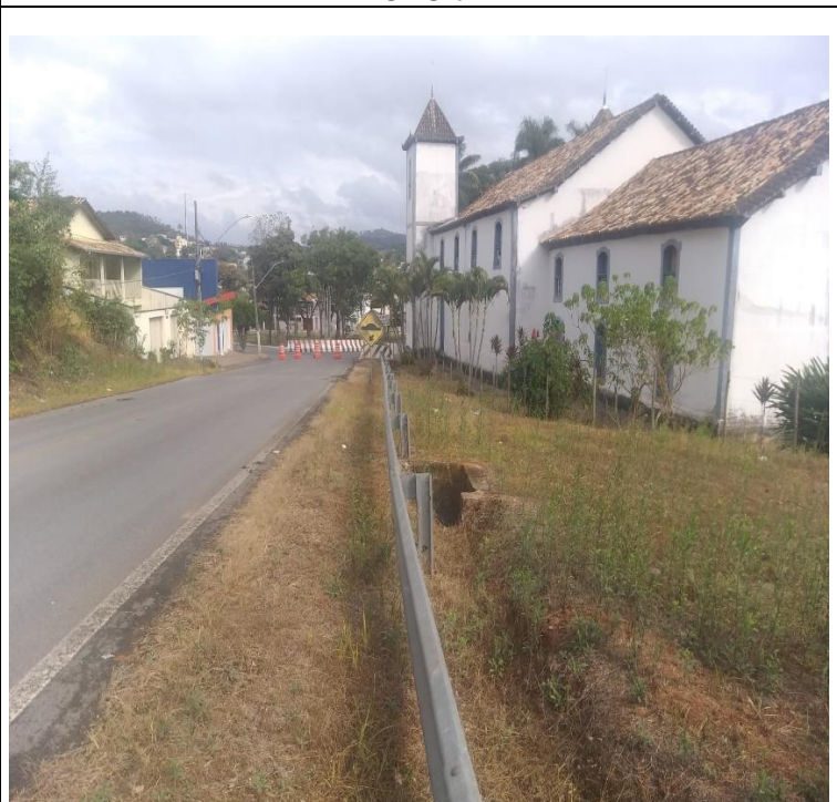
Descrição: Construção da Canaleta
