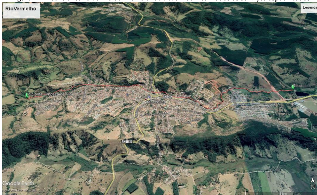
Figura 1 - Trecho urbano do Rio Vermelho onde devem ser realizados os serviços especificados.
