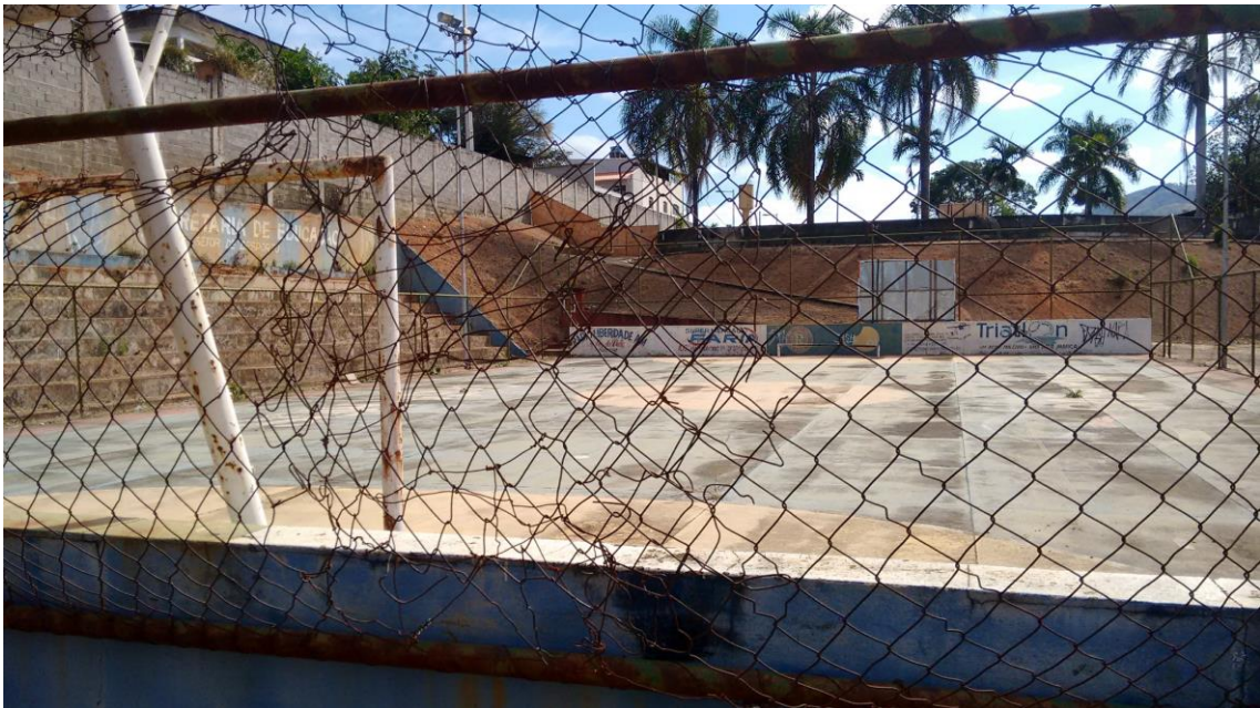
(Foto 07 – Vista Parcial interna)
