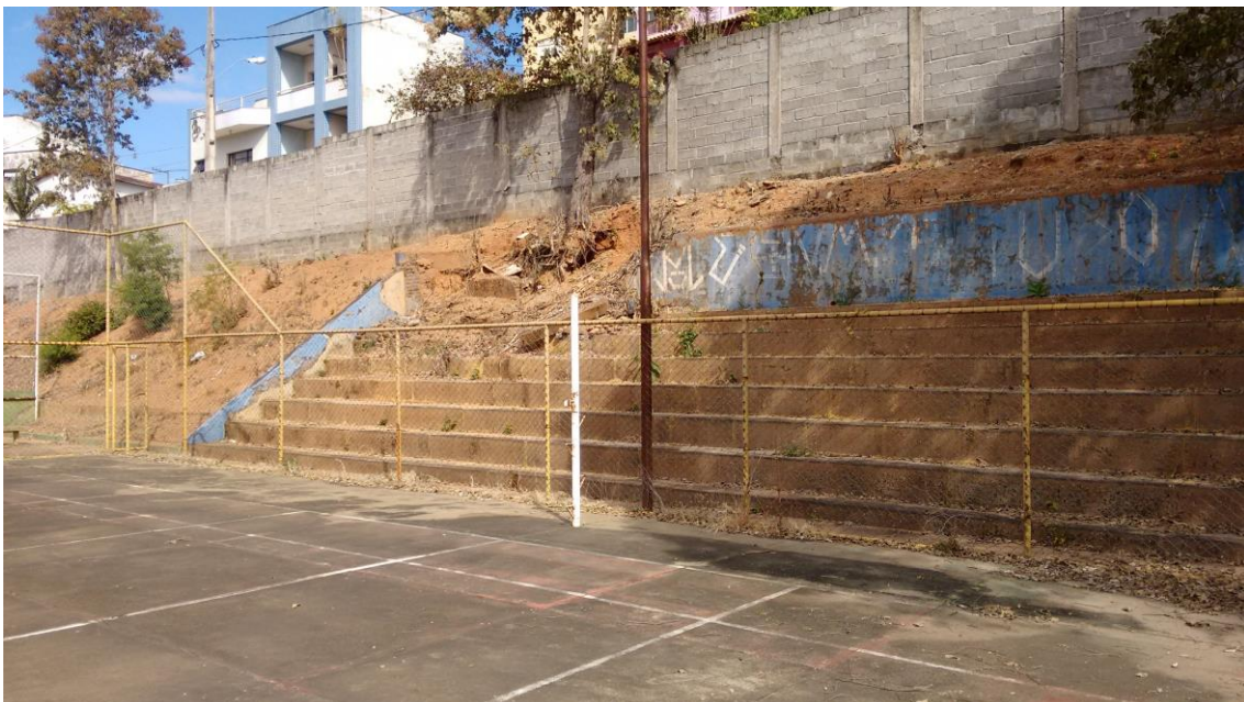
(Foto 12 – Vista Parcial Interna)
