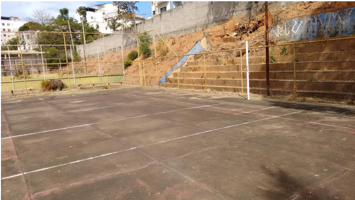
(Foto 11 – Vista Parcial Interna)
