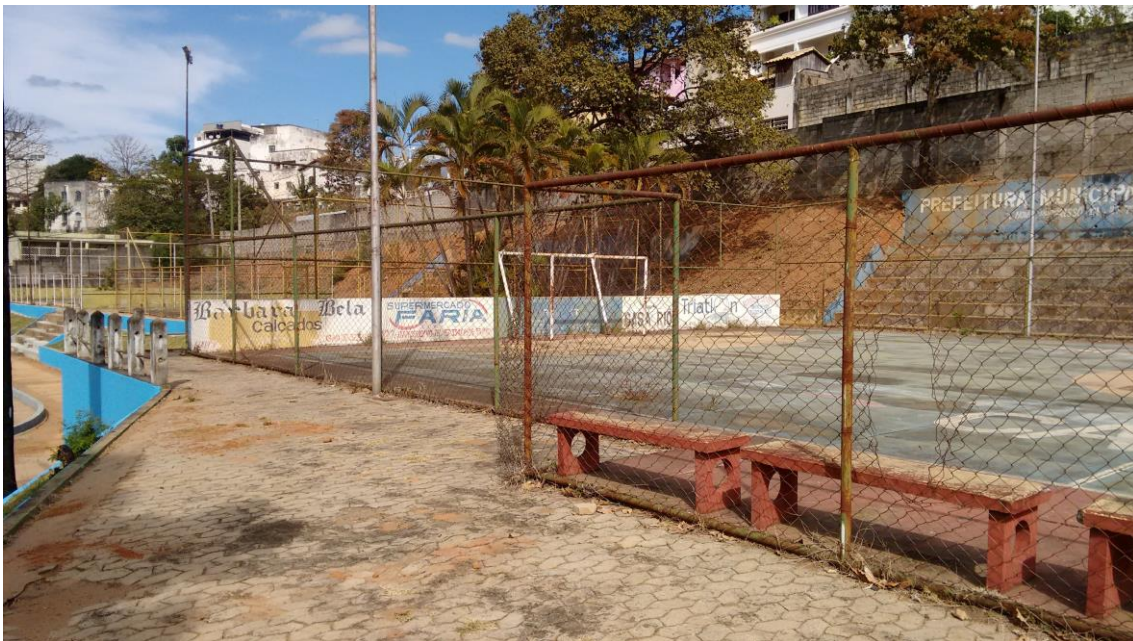
(Foto 04 – Vista Parcial externa)
