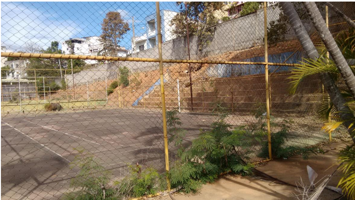
(Foto 08 – Vista Parcial Interna)
