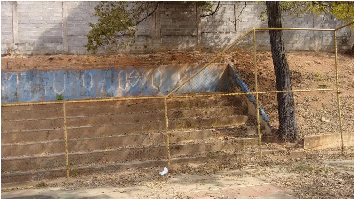
(Foto 13 – Vista Parcial Interna)
