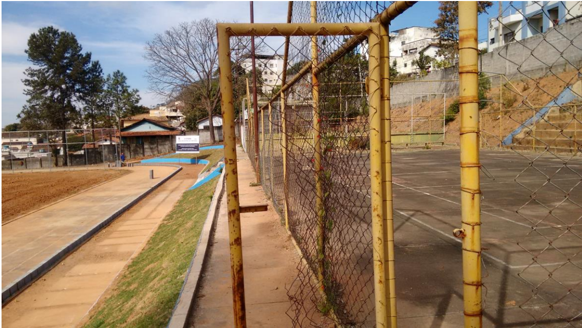
(Foto 09 – Detalhes do gradil da quadra de voley)
