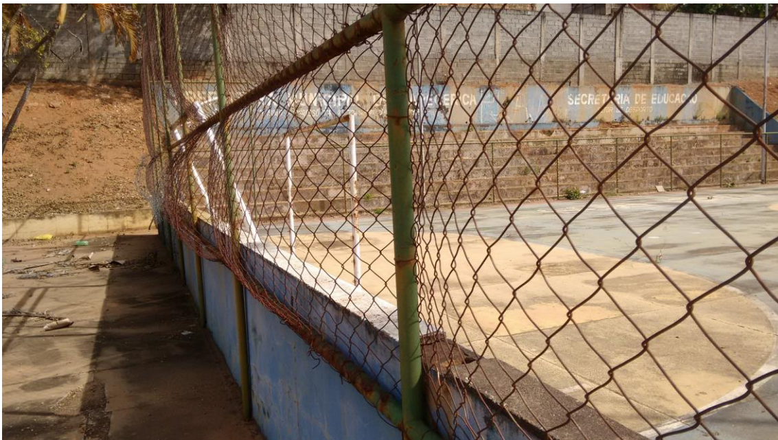
(Foto 06 – Vista Parcial Interna)
