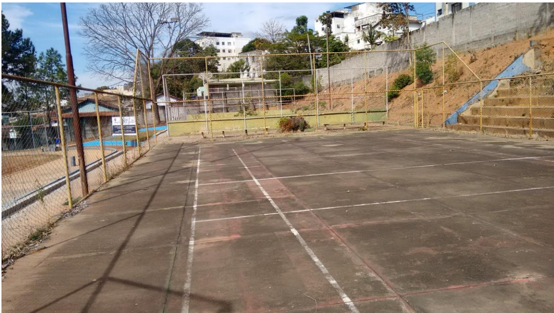
(Foto 10 – Vista Parcial Interna)
