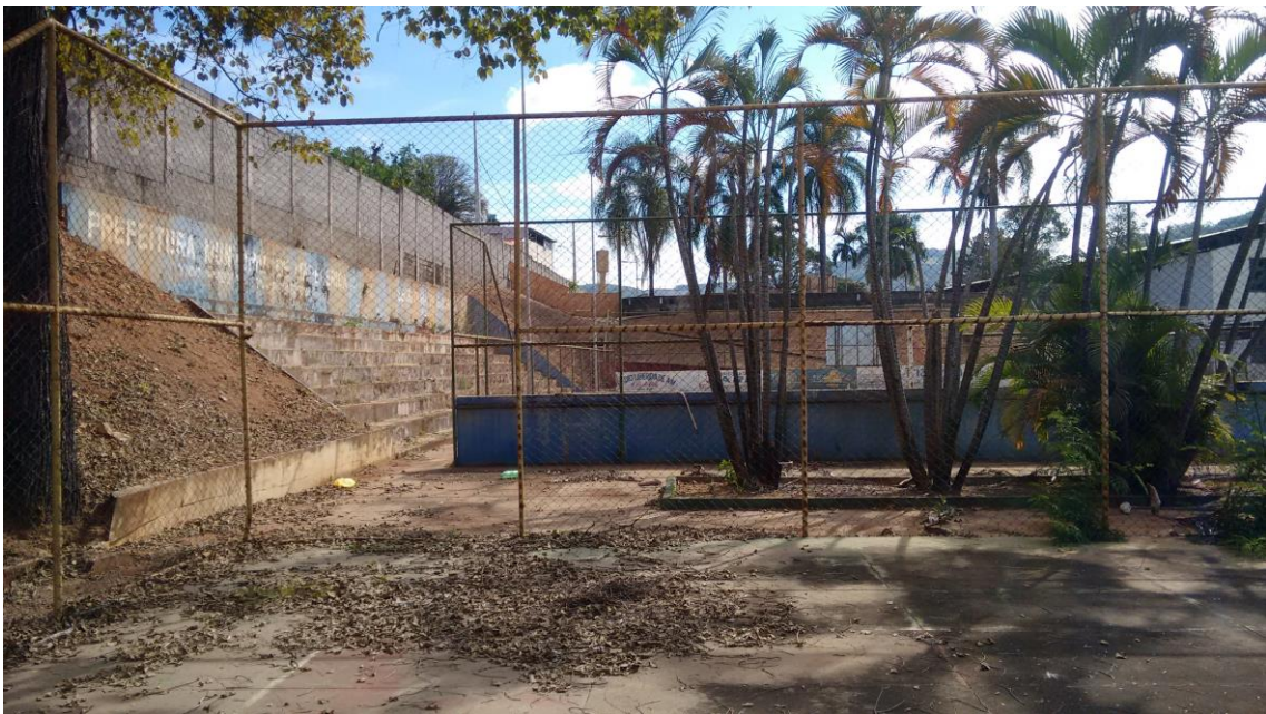
(Foto 14 – Vista Parcial Interna)
